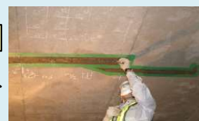
ひび割れ充填
