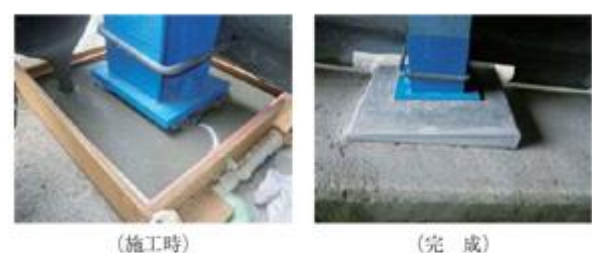
図-10 自己治癒材料の使用事例（スノーシェッド）
