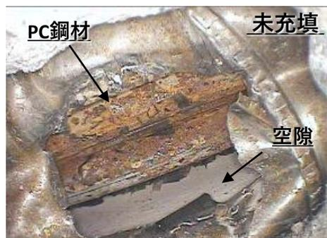
構造物を削孔し、CCDカメラで内部状況を確認することで
